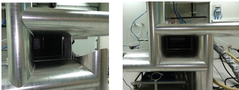
Figura 4.21 - Montagem e ajuste das chapas na instalação da JDEUS.
